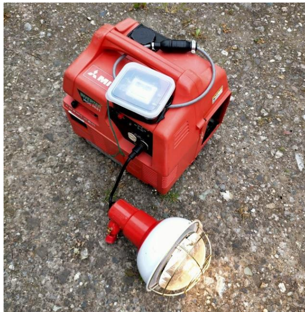
図 1. 発電機の動作確認の様子
